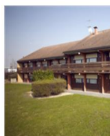
HÔTEL-RESTAURANT "CAMPANILE" CHÂLONS-EN-CHAMPAGNE SAINT-MARTIN-SUR-LE-PRÉ ★★★
