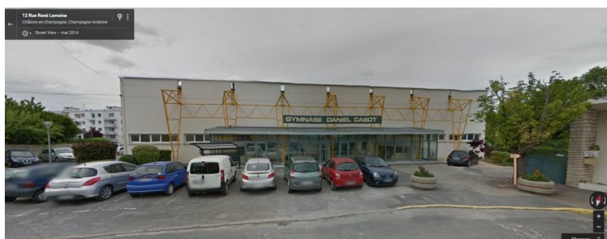
Salle de compétition extérieure
